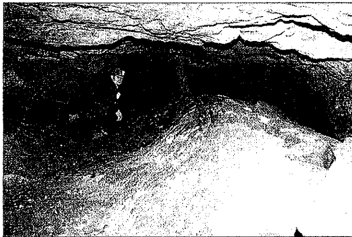
Photo n°3 - Soufflage du mur : Guide technique "cavités souterraines"
