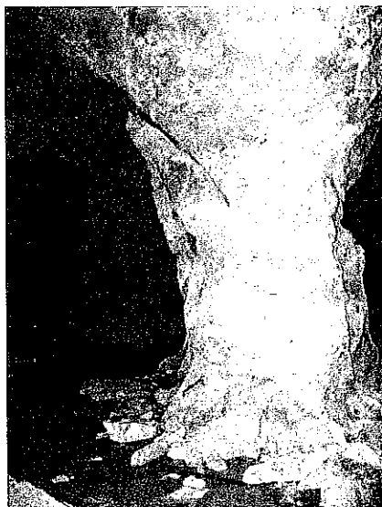
Photo n°1 - Rupture de pilier : Guide technique "cavités souterraines"
