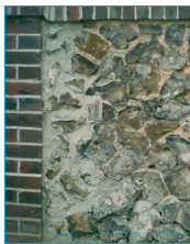
Mur en silex et chaîne en brique.
