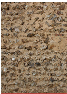
Maçonnerie de silex
