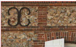
Maçonnerie de brique et silex.
