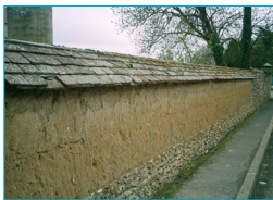
Mur en terre crue, soubassement silex. Broué.
