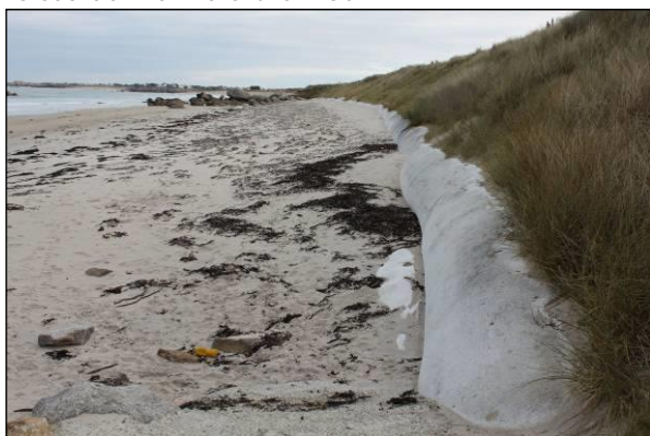
Renforcement du pied de dune vers Boutrouilles
