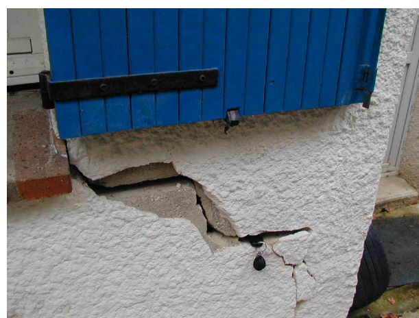
Fissures ouvertes sur murs extérieurs
