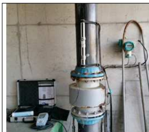
Contrôle-débitmètre-entrée-STEP-Pernes-Village
