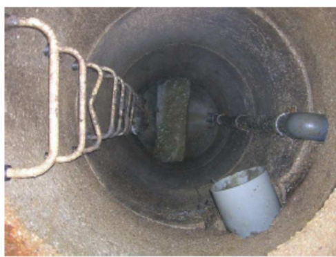
Déversoirs d'orage de la STEP
